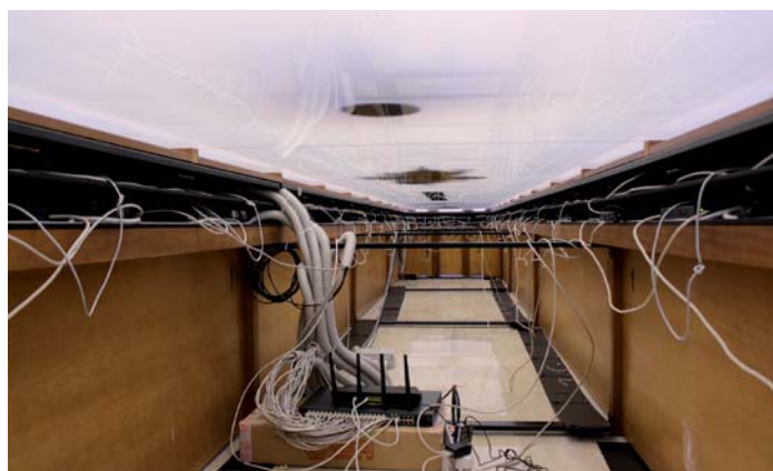
Sotto le postazioni, attraverso una botola, si accede all'interno dell'immenso tavolo della Sala Meeting, dove sono posizionati i daisyNET e i cavi di collegamento delle postazioni.
