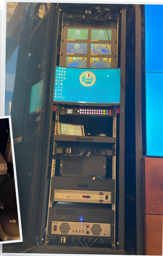
Sulla sinistra del mosaico in alto: telecamere VC-B30U Lumens che, quando vengono attivate, fuoriescono dalla struttura autoportante.
